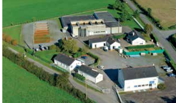
Usine d'assainissement des eaux de la CARENE, Campbon
