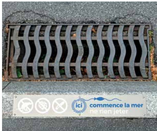
Une nouvelle signalétique devant les bouches de canalisations d'eaux pluviales
